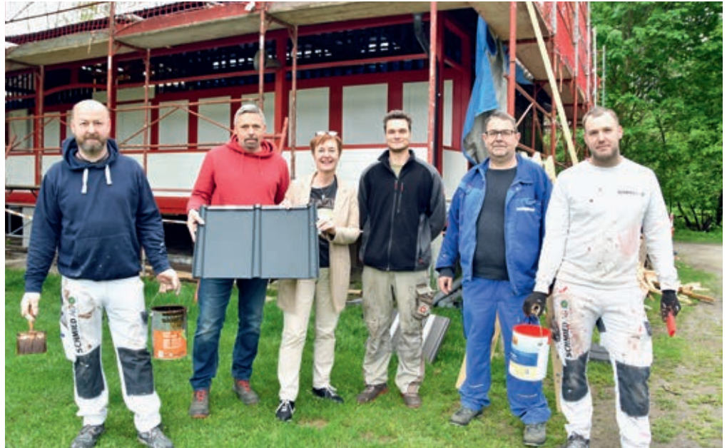
Die Pflege dieser Freizeitanlage erfordert immer viel Arbeit – im Frühjahr wurde eine Generalsanierung durchgeführt.
