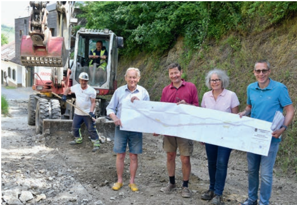
In erster Linie steht die Sanierung des alten Leitungsnetzes unter der Erde im Vordergrund. Damit zwingend verbunden ist eine neue Straßenoberfläche. Im Buriweg werden zusätzliche Ausweibuchten eingebaut, die der Verkehrssicherheit dienen.
