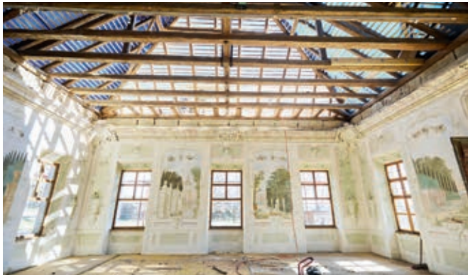
2005 wurde der Innenraum, 2023 das Dach des barocken Gartenhauses saniert.
