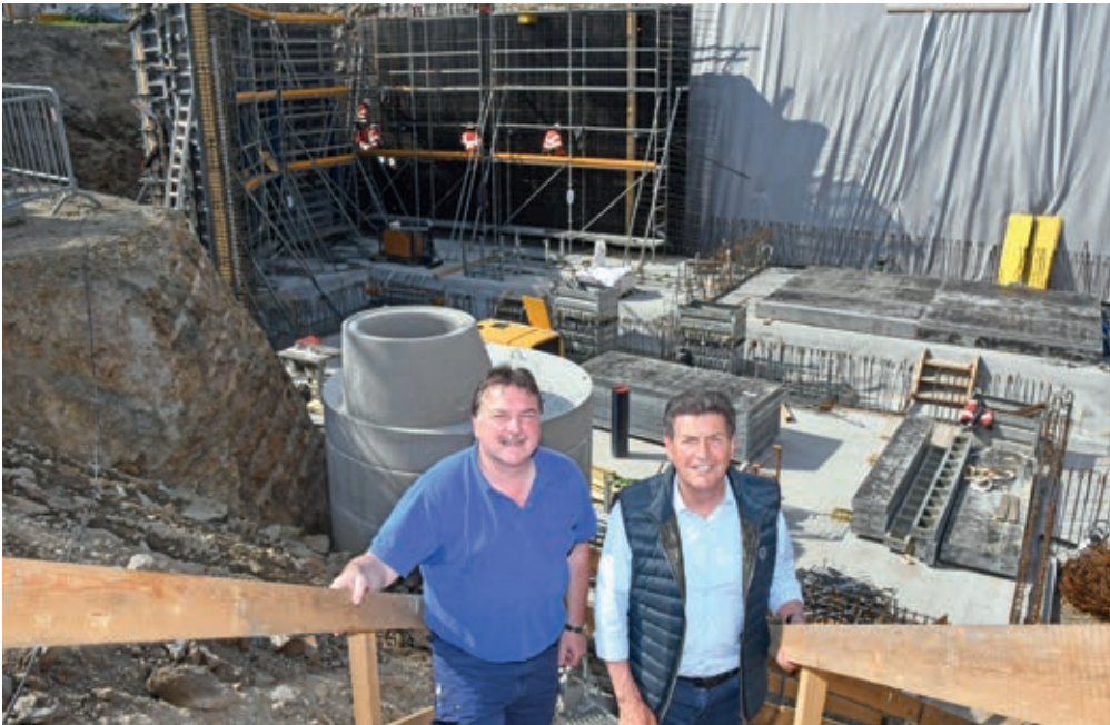
Wassermeister Martin Berner und Bürgermeister Harald Leopold bei der Besichtigung der beeindruckenden EVN-Baustelle am Loiserberg.
