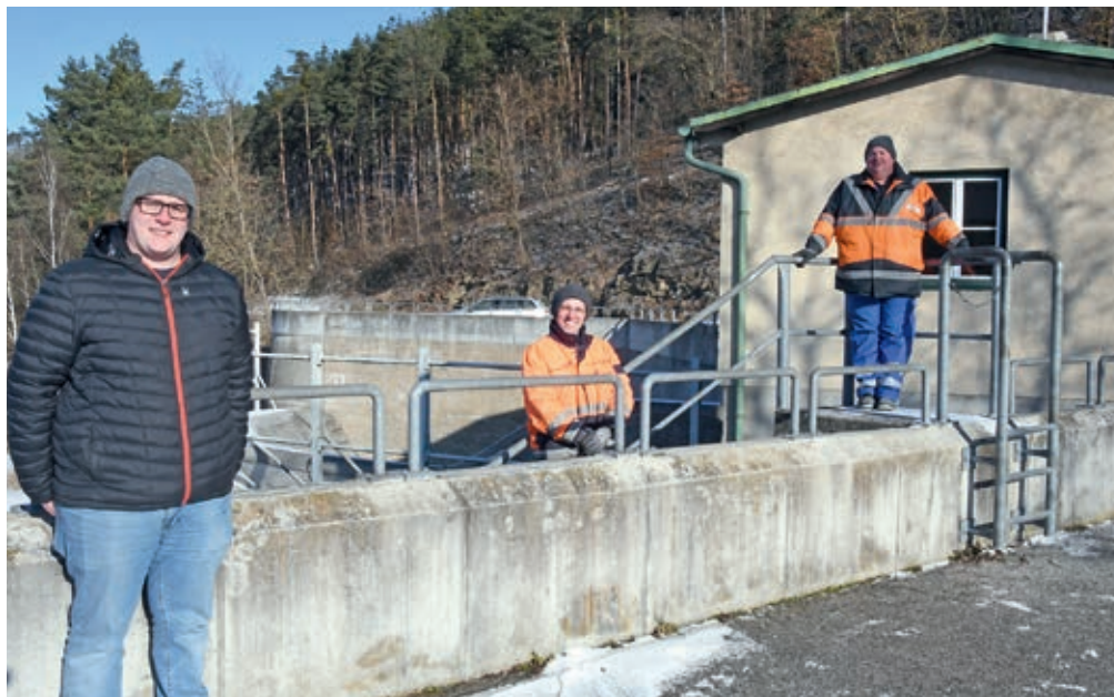
Kontrollgang der Gemeindemitarbeiter Jürgen Muhm, Josef Strom und Michael Nastl, der jetzt für die Wasserstandsmessungen und die Pflege der Anlage zuständig ist.
