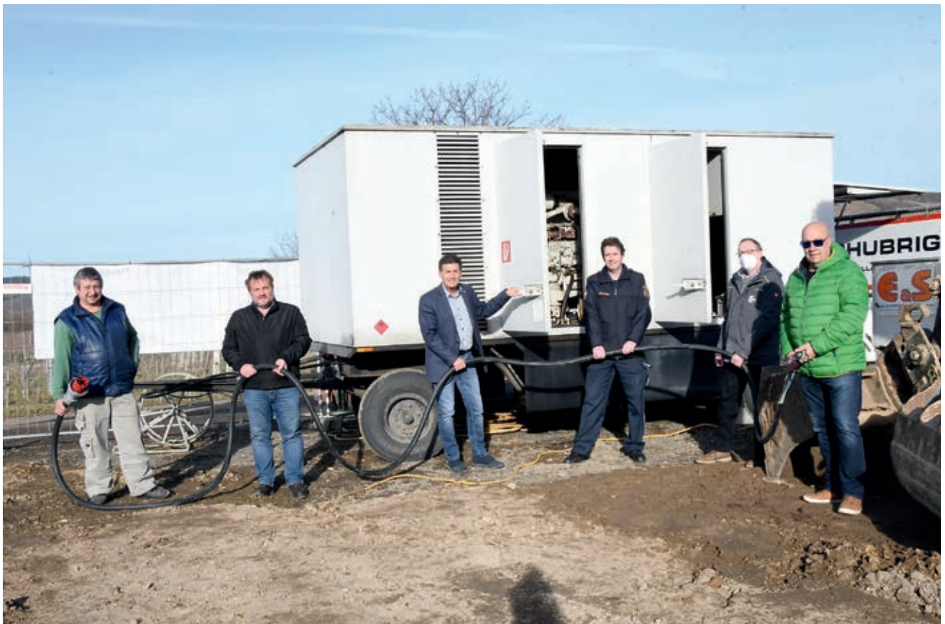
Testbetrieb gelungen: Wenn alle Stricke reißen, dann kommt das starke Generatorkabel zum Einsatz.
